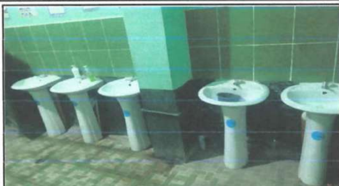
Foto 1: Sustrucción de grifería y drenajes en baño de primer nivel y Sustrucción de Azulejos en baños de primer y segundo nivel.
